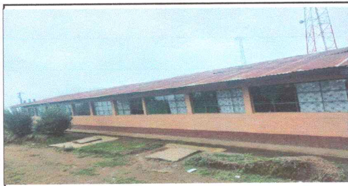
Foto 5: Sustrucción de lámina, por lámina troquelada aluzinc calibre 26. Módulo 1.
