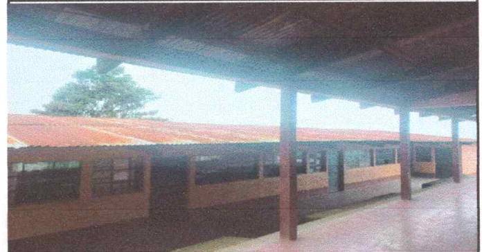
Foto 4: Sustrucción de capote de lámina para lámina troquelada. Módulo 1.
