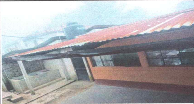
Foto 1: Sustrucción de lámina, por lámina troquelada aluzinc calibre 26. Módulo 1.
