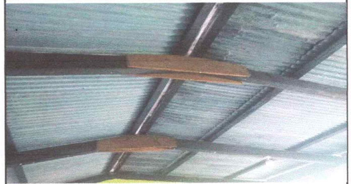
Foto 2: Sustrucción de Estructura de madera, por metal. Módulo 1.
